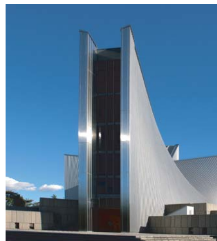
東京カテドラル聖マリア大聖堂・外壁改修工事(東京都文京区) 設計:大成建設(株) 施工:大成建設(株) 技術監修:(株)丹下都市建築設計 製品:特注製品 素材:フェライト系ステンレス
