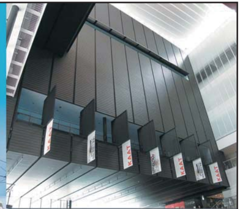
室内部 アトリウム内壁/天井
